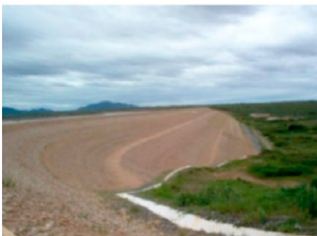
Figura 15. Proteção do talude de jusante em cascalho.
