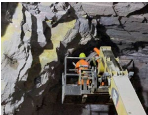
Figura 12. Escavações subterrâneas. Remoção de blocos soltos.
