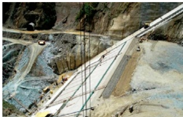
Figura 17. Construção de uma barragem de enrocamento com face em concreto e plinto de fundação. Fonte: COBA, S.A / Banco de Imagens ANA
