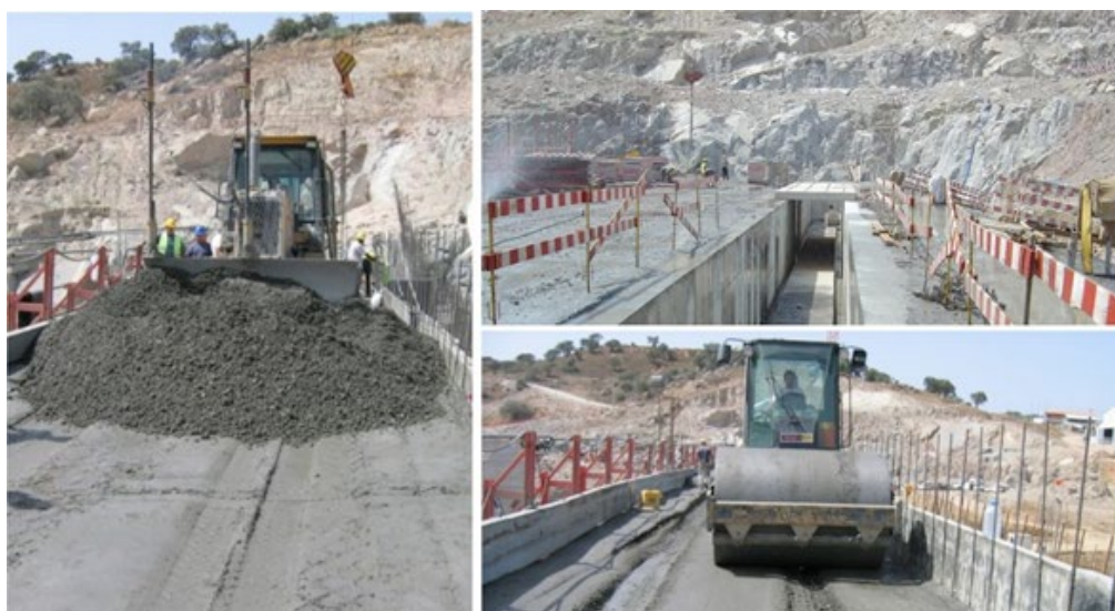
Figura 30. Aspectos da construção de blocos em CCR. Fonte: EDIA, S.A / Banco de Imagens ANA
