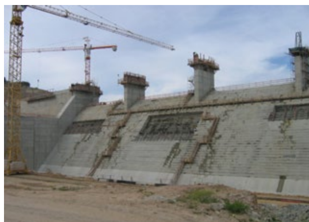
Figura 28. Barragem de concreto compactado a rolo (CCR) (Barragem de Pedrógão, Portugal). Fonte: LNEC / Banco de Imagens ANA
