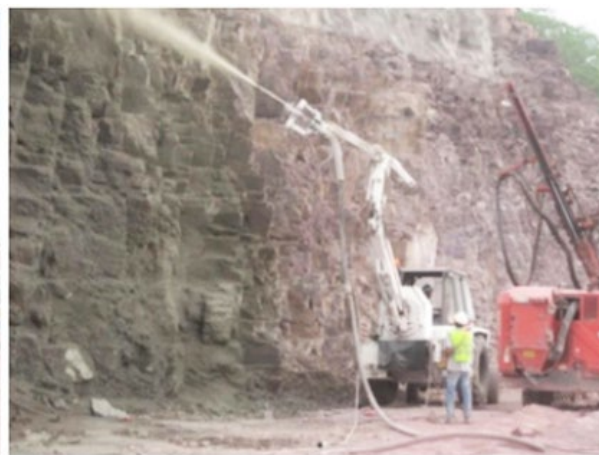
Figura 7. Projeção de concreto. Fonte: COBA, S.A / Banco de Imagens ANA
