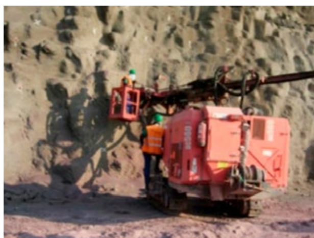
Figura 8. Aplicação de chumbadores após concretagem. Fonte: COBA, S.A / Banco de Imagens ANA
