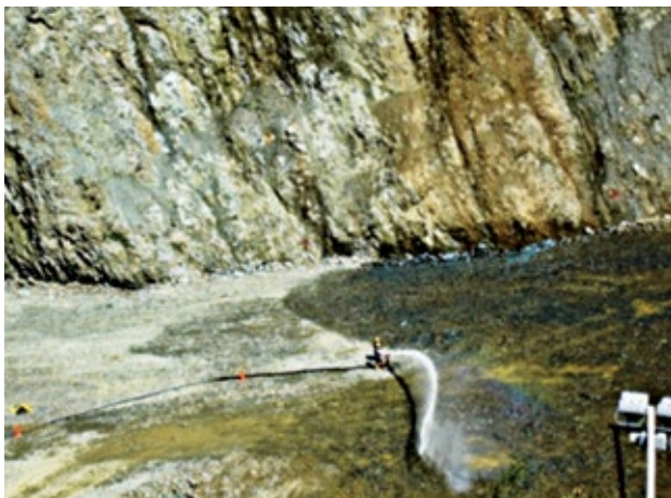
Figura 20. Irrigação do aterro de enrocamento. Fonte: COBA, S.A / Banco de Imagens ANA
