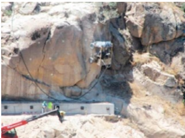
Figura 9. Viga de ancoragem ativa. Fonte: COBA, S.A / Banco de Imagens ANA
