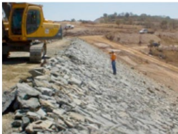
Figura 13. Proteção do talude de montante em enrocamento.
