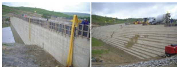
Figura 27. Barragem de concreto compactado a rolo (CCR). Barragem do Mamoeiro, CE. Fonte: COBA, S.A / Banco de Imagens ANA
