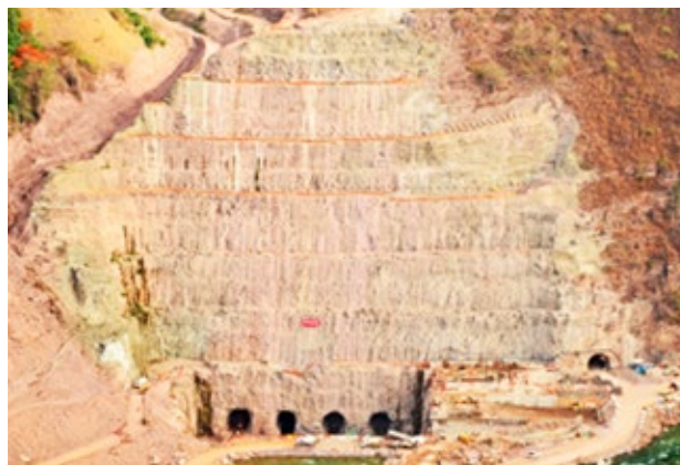
Figura 4. Escavação a céu aberto da saída do segundo circuito hidráulico de Cambambe, Angola. Fonte: COBA, S.A. / Banco de Imagens ANA
