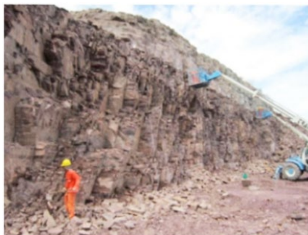
Figura 6. Remoção de blocos soltos. Fonte: COBA, S.A / Banco de Imagens ANA
