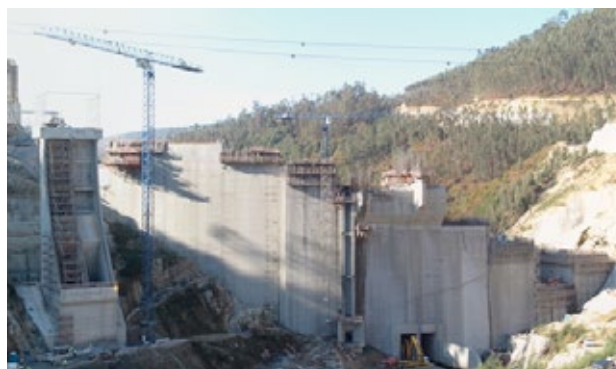
Figura 25. Barragem de concreto convencional (Barragem de Ribeiradio, Portugal). Fonte: COBA, S.A / Banco de Imagens ANA
