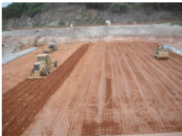
Figura 18. Aterro homogêneo. Operações de escarificação e de compactação.
