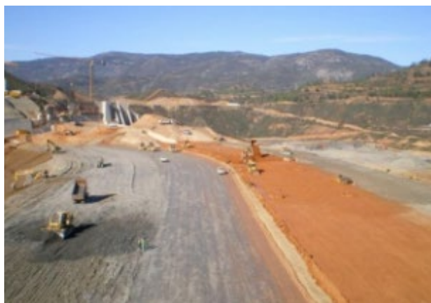
Figura 19. Aterro zonado. Operações de espalhamento e de compactação.
