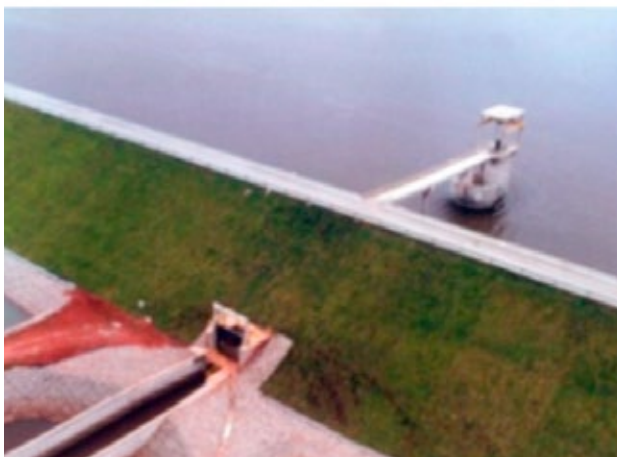
Figura 14. Proteção do talude de jusante em cobertura vegetal.
