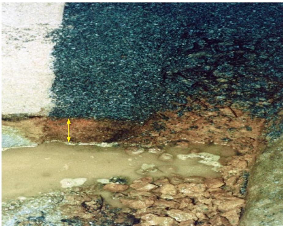
Figura 5. Colmatção das camadas de areia, pedrisco e brita na zona de oscilação do NA (seta) junto ao dreno de pé de uma barragem de terra pela ação de ferro-bactérias.
