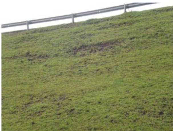
Figura 21. Talude de jusante da barragem com deslizamentos superficiais.
