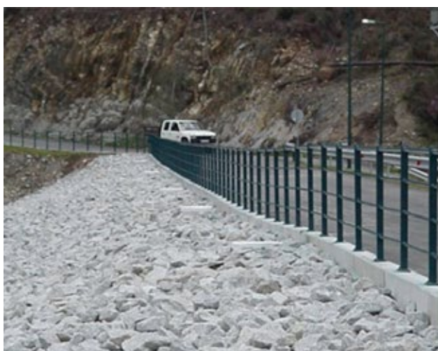
Figura 12. Deformação excessiva na crista da barragem indicando deslizamento do talude. Fonte: COBA, S.A. / Banco de Imagens ANA
