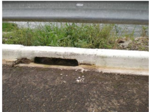
Figura 19. Saída da água obstruída, necessitando manutenção.
