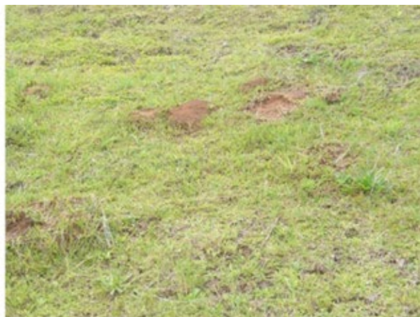
Figura 22. Formigueiros no talude de jusante.
