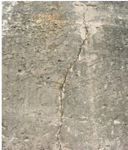
Figura 31. Fissura subvertical de origem térmica ( e = 2,0 mm), no paramento de jusante de uma barragem tipo gravidade. Fonte: SBB Engenharia / Banco de Imagens ANA
