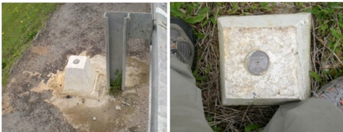
Figura 54. Marco topográfico com peça destinada ao encaixe de bastão (menor precisão que a utilização de miras de alta precisão estacionadas nos tacos de nivelamento).
