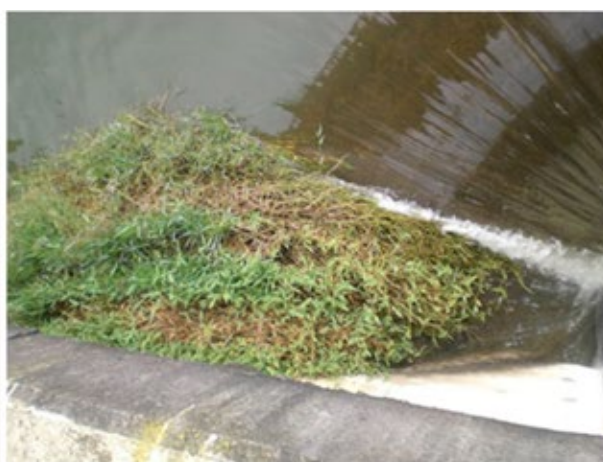
Figura 47. Vegetação a ser arrastada para o interior do poço do vertedouro.
