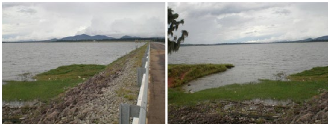
Figura 45. Acumulação de vegetação sobrenadante no reservatório, junto ao talude de montante da barragem.
