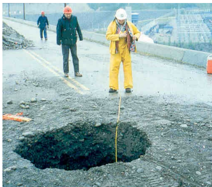
Figura 15. Afundamento (Sinkhole) na crista da barragem de Bennett, Canadá. Water Power & Dam Construction, Fev 1997 / Banco de Imagens ANA
