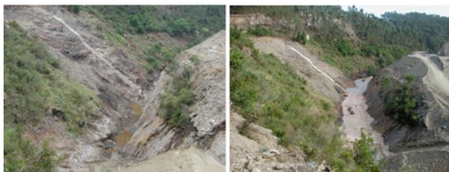
Figura 9. Geometria do vale desfavorável (muito encaixado) para uma barragem de aterro, potencializando a ocorrência de efeito de arco.
