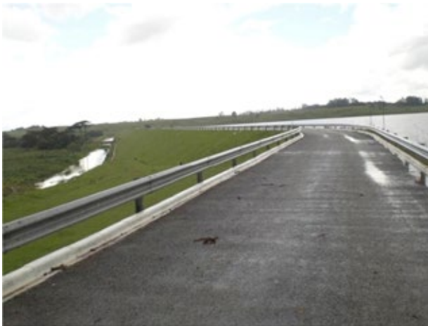
Figura 18. Água acumulada no pavimento, resultante de drenagem deficiente.
