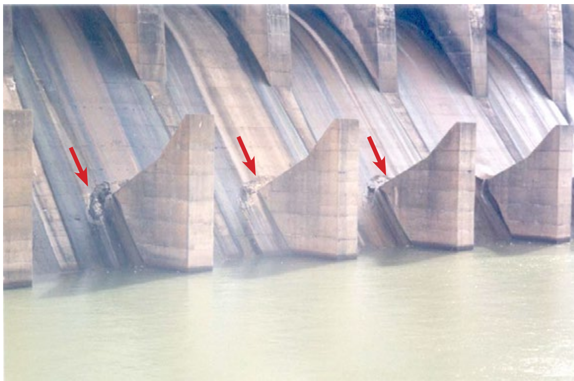
Figura 39. Exemplo de cavitação no concreto por tipo jato cavitante.
