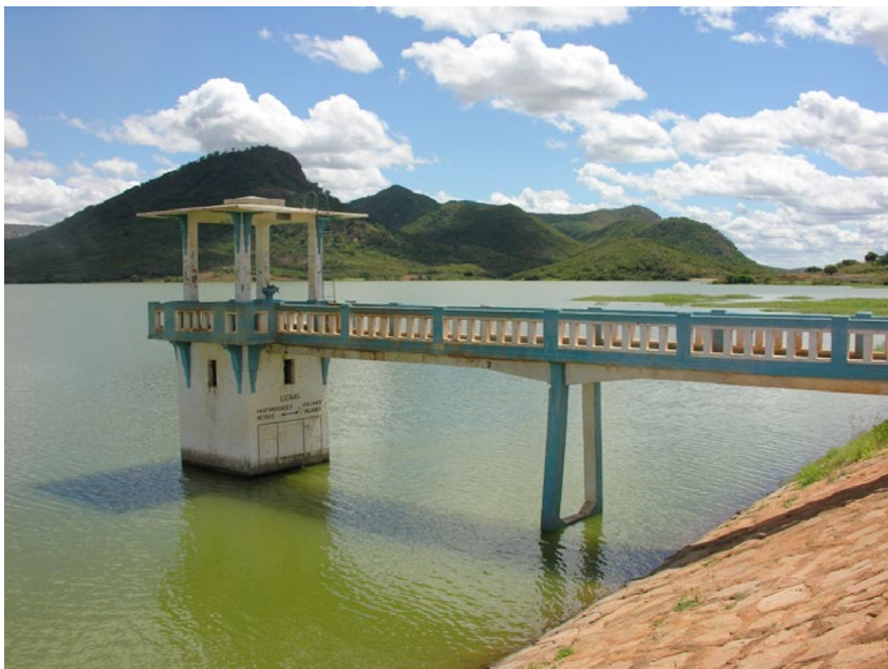
Figura 34. Tomada de água em torre com acesso, por passadiço, à barragem de aterro. Barragem de Lucrécia, RN.
