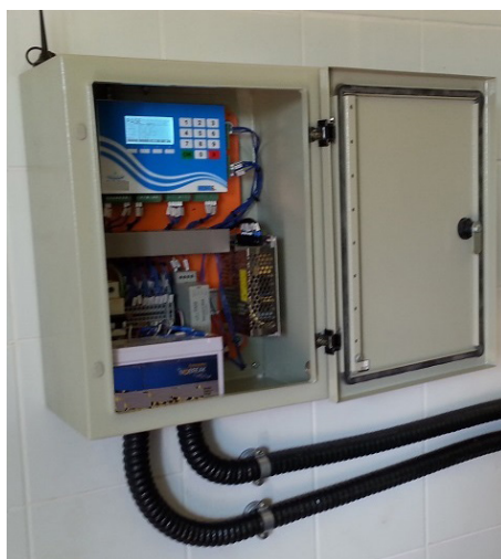
Figura 22. Exemplo de instalação de elemento secundário em caixa metálica.
