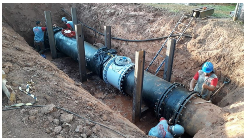
Figura 4. Instalação de um macromedidor de água em adutora.
