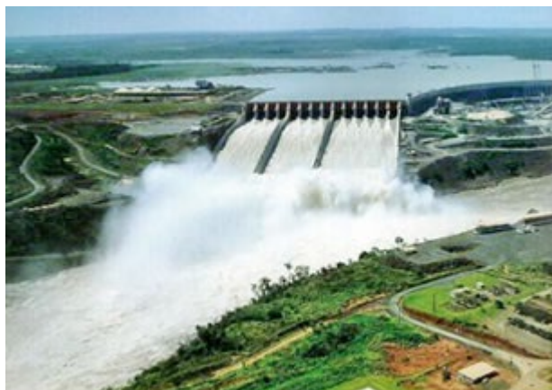
Figura 1.24. Vertedouro da barragem de Itaipu (Brasil). Fonte: COBA.
