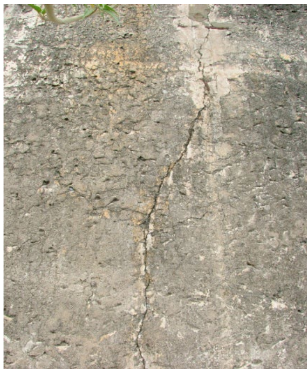
Figura 1.25. Fissura subvertical de origem térmica ( e = 2,0 \text{ mm} ), no paramento de jusante de uma barragem.
