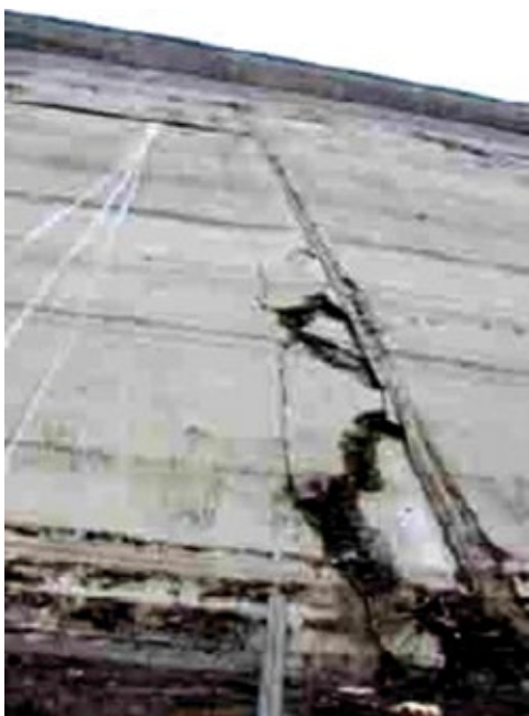
Figura 10. Danos causados na laje de concreto da barragem de enrocamento de Zipingpu (China).
