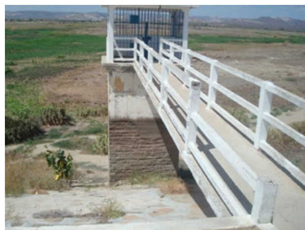
Figura 1.13. Barragem de Santa Luzia (Paraíba) – passadiço e tomada de água. Fonte: COBA.
