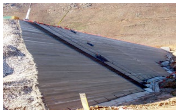
Figura 1.17. Aspecto da junta perimetral. Fonte: COBA.
