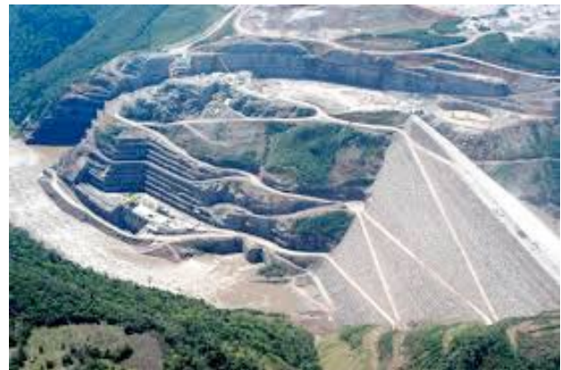
Figura 1.18. Talude de jusante da barragem de Foz do Areia (Paraná). Fonte: COBA.
