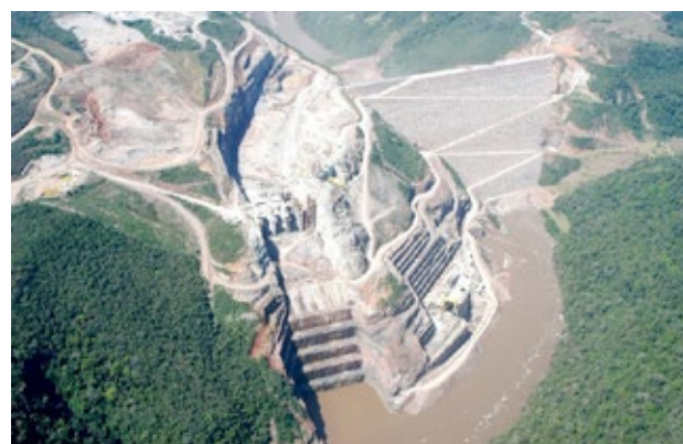
Figura 1.19. Ombreiras da barragem de Campos Novos (Santa Catarina). Fonte: COBA.
