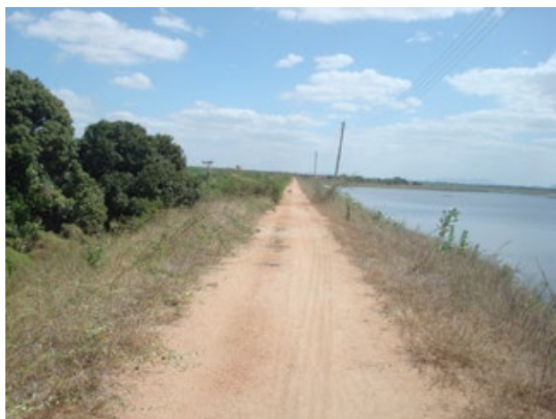
Figura 1.4. Barragem de Direito (Paraíba) – vista da crista com arbustos de grande porte a jusante. Fonte: COBA.
