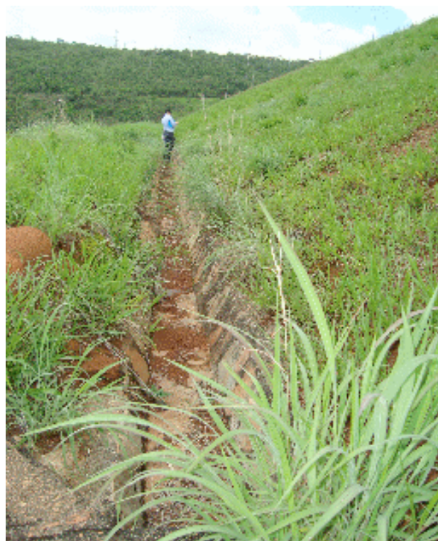
Figura 1.5. Canaletas de drenagem necessitando de limpeza de solo no fundo. Fonte: COBA.
