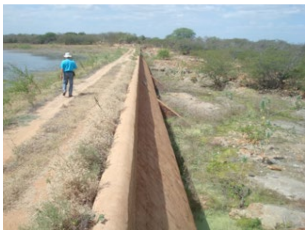
Figura 1.10. Barragem de Direito (Paraíba) – soleira descarregadora da barragem. Fonte: COBA.
