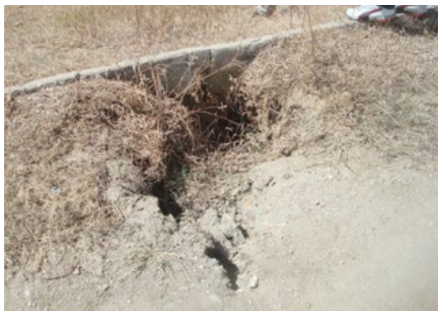
Figura 1.3. Barragem de Baião (Paraíba) – Erosão do talude de jusante. Fonte: COBA.
