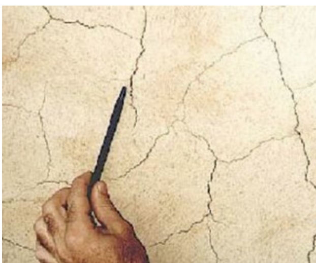
Figura 19. Aparecimento de fissuras. Fonte: COBA / Banco de Imagens ANA
