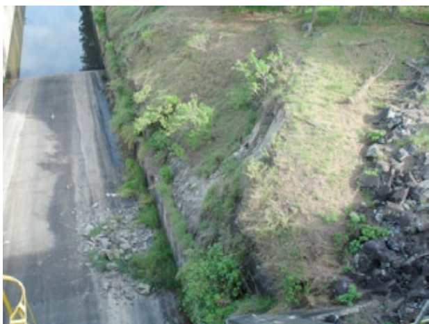
Figura 1.11. Queda de blocos de rocha do talude lateral na calha do vertedouro da barragem do Jaguari (São Paulo).
