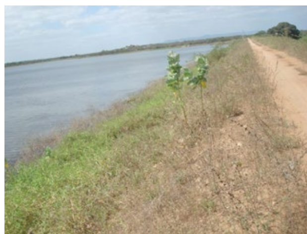
Figura 1.1 – Barragem de Direito (Paraíba) – talude de montante com vegetação. Fonte: COBA.
