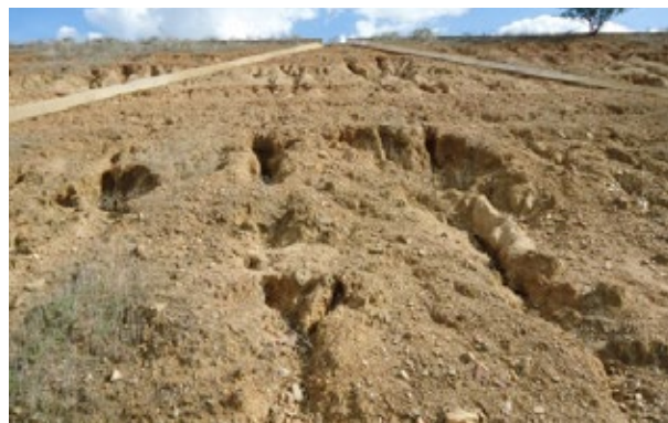
Figura 21 – Intenso ravinamento no paramento de jusante
