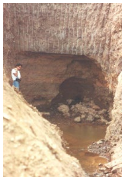
Figura 13 – Surgência em torno do conduto da descarga de fundo Fonte: Banco de Imagens ANA
