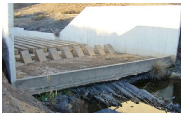
Figura 26 – Erosão a jusante da bacia de restituição do vertedouro Fonte: Banco de Imagens ANA
