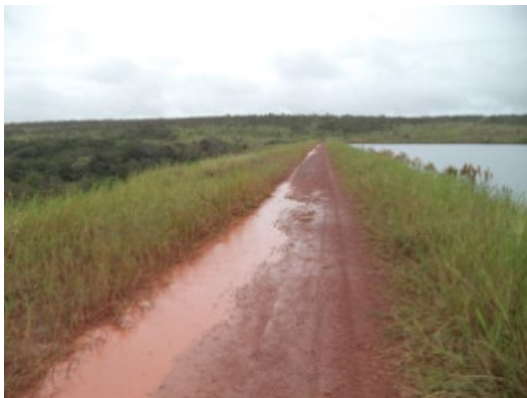
Figura 19 – Acumulação da água das chuvas no coroamento
