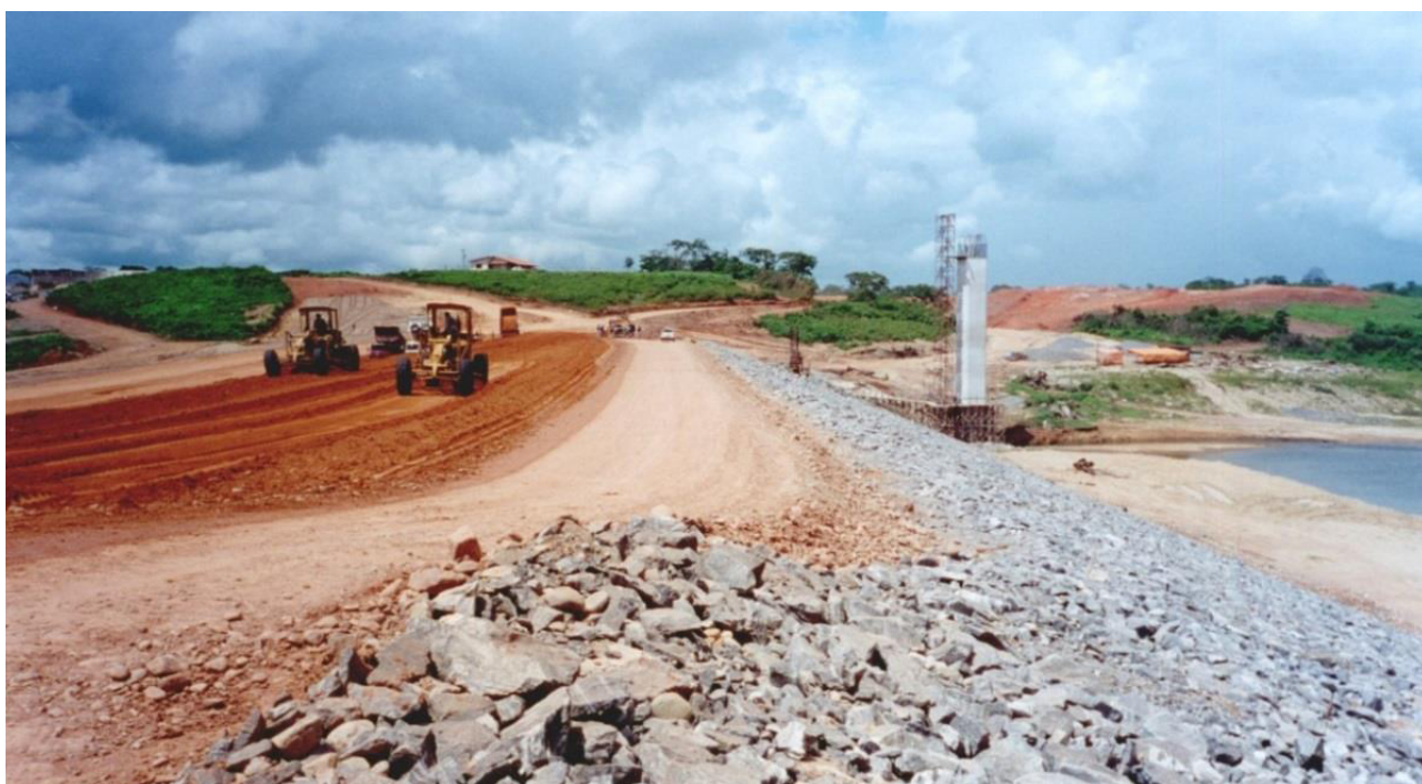
Figura 8. Barragem de Aracoiaba, CE – construção H=35\text{m} , V=170\text{ hm}^3 , L=2000\text{ m}
