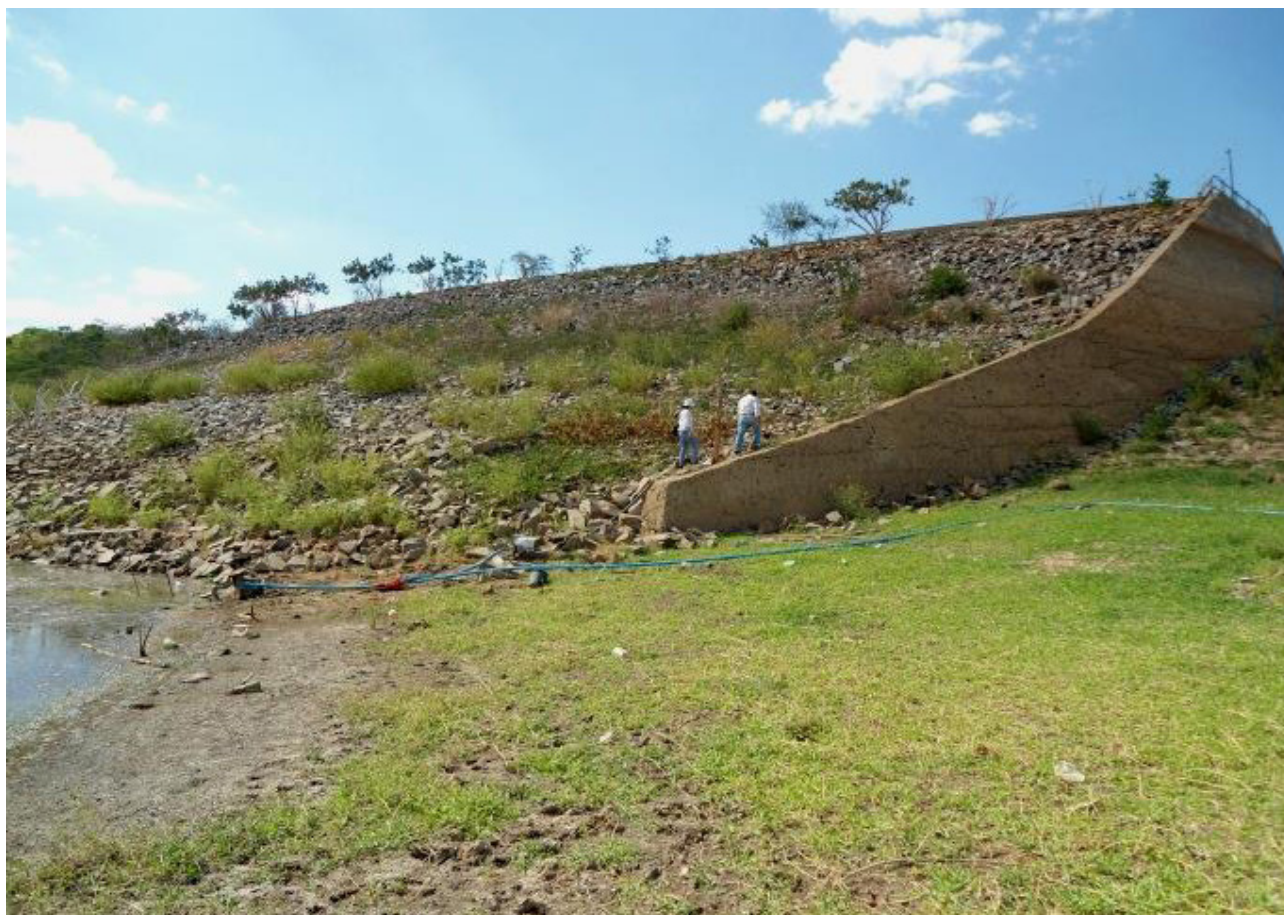
Figura 22. Barragem de Capoeira, Paraíba – talude de montante H=36\text{m} , V=53\text{ hm}^3 , L=490\text{ m}
