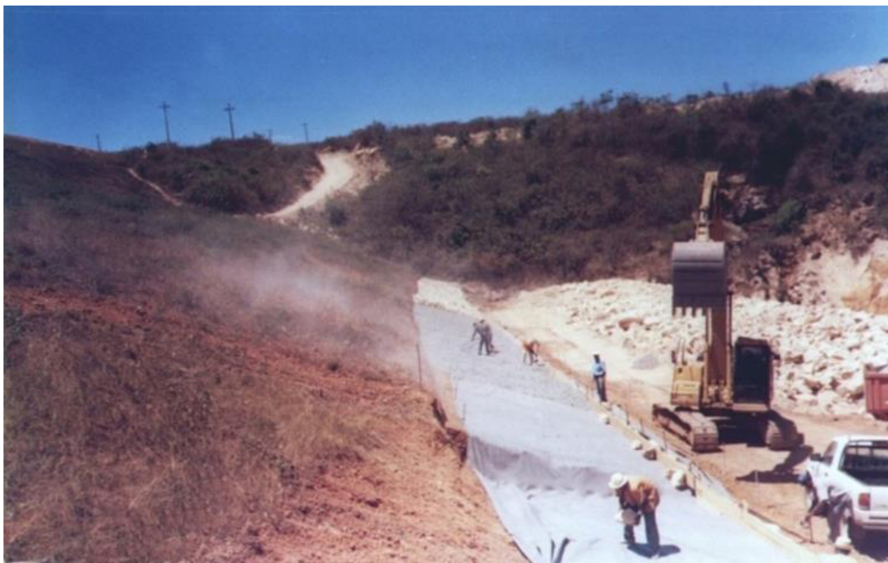
Figura 24. Açude Jaburu I, CR – recuperação, paramento de jusante H=48\text{m} , V=210\text{ hm}^3 , L=770\text{ m}
