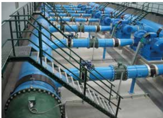
Figura 1. Medidores de vazão de água em uma estação de bombeamento.
