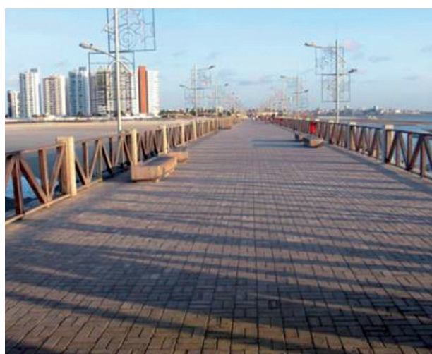
Foto 62: Aspecto do espigão de Ponta da Areia. Imensa estrutura perpendicular à linha de costa que interfere na dinâmica sedimentar costeira
