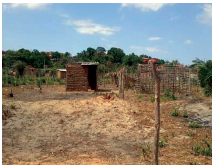
Foto 64: Construção de casas rústicas com madeira entrelaçada e taipa em loteamento clandestino no interior do Parque Estadual do Bacanga
