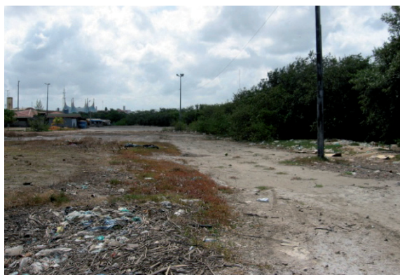
Foto 49: Aterro sobre mangue do rio Bacanga, próximo ao Mercado do Peixe, na região central de São Luís
