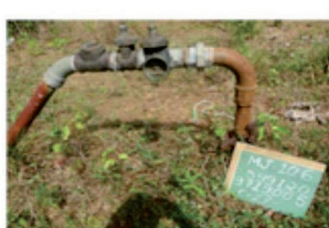
Poço MJ 106 (0599120/9719005). Sem laje de proteção nem perímetro de proteção
