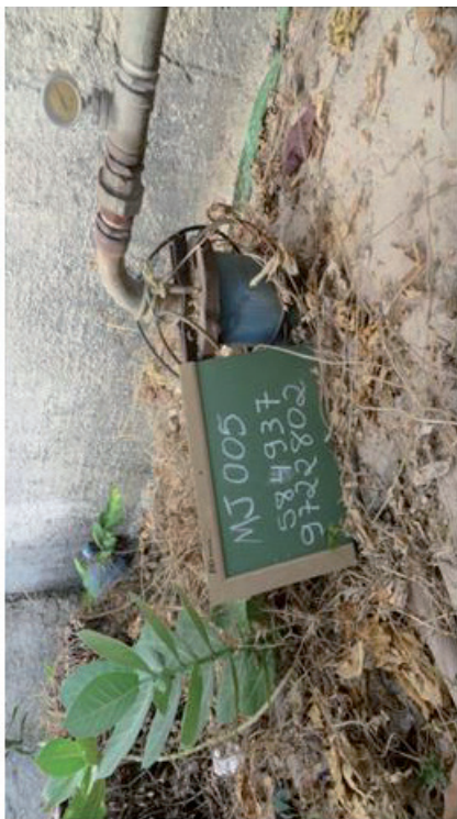
Município de São Luís. Vicente Fialho (COHAMA) Coord.: 584937/9722802 Poço tubular em meio ao lixo e sem proteção sanitária
