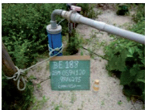
Poço BE 188 (0594120/9706295). Sem laje de proteção e com aspecto de abandono em meio ao matagal
