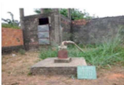
Poço SA 109 (0590856/9719118). Com laje de proteção e dentro de área de proteção não cimentada
