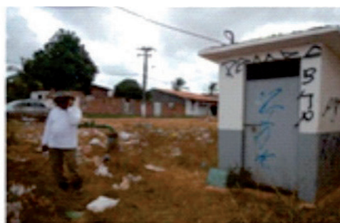
Poço SA 110 (0591254/9719009). Sem laje de proteção e sujeito ao acúmulo de lixo
