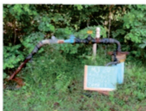
Poço MJ 201 (0594115/9709748). Sem laje de proteção e em meio ao matagal
