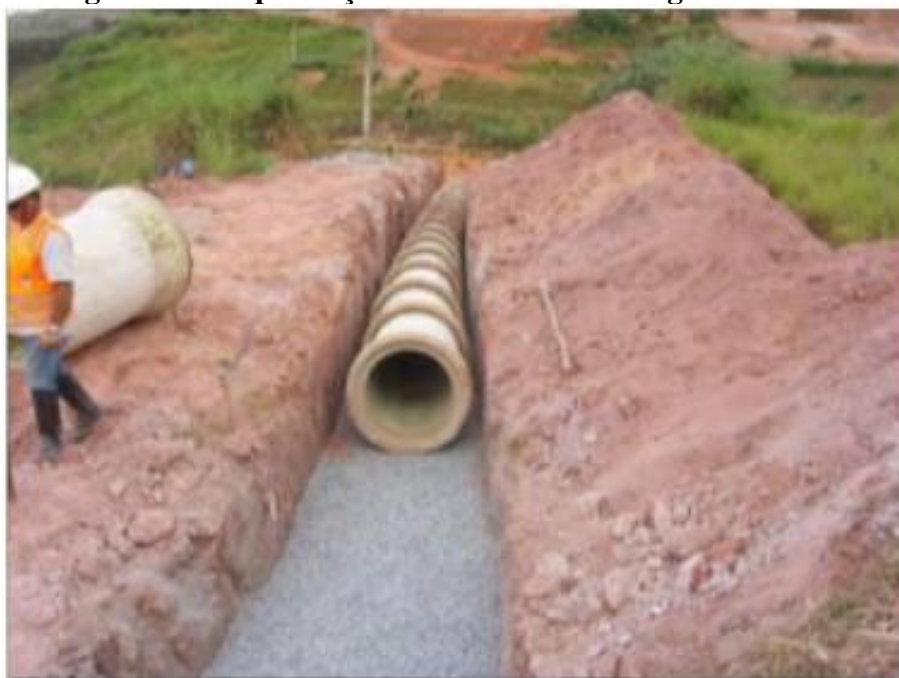
Figura 19 - Implantação do sistema de drenagem do aterro
