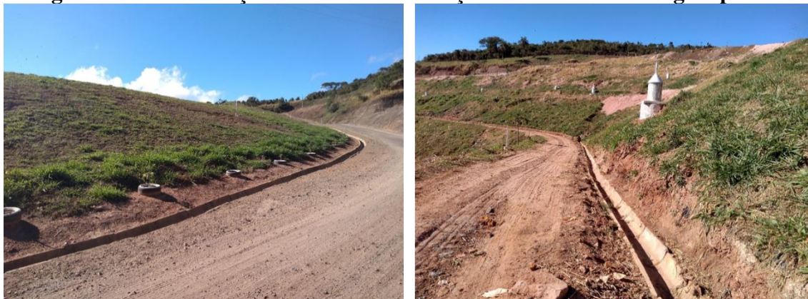
Figura 49 – Manutenção das vias de circulação e sistema de drenagem pluvial
