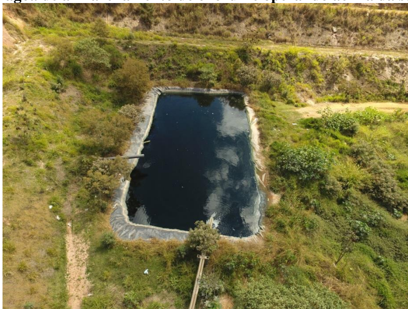
Figura 27 – Lagoa de armazenamento de chorume operando acima da sua capacidade
