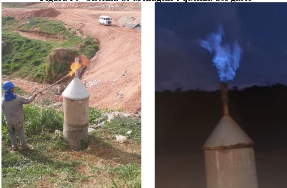
Figura 50– Sistema de drenagem e queima dos gases
