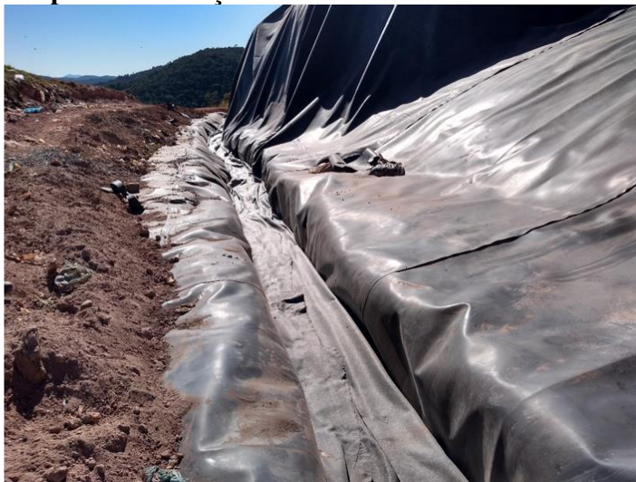
Figura 51 – Sistema de impermeabilização de fundo e de laterais
