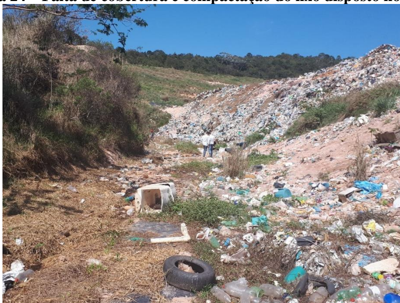
Figura 24 – Falta de cobertura e compactação do lixo disposto no aterro
