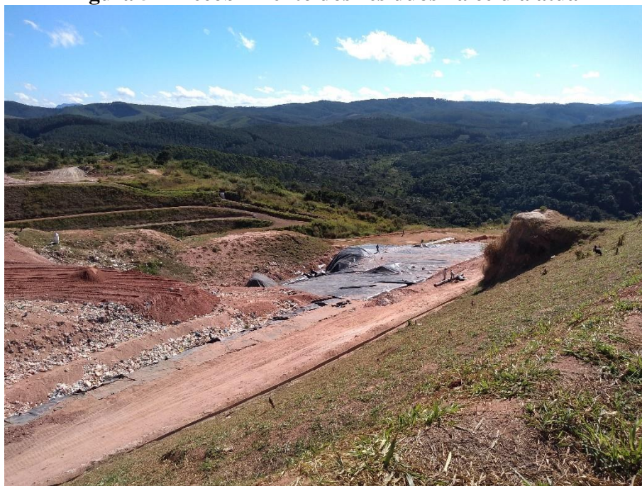
Figura 52- Recobrimento dos resíduos na célula atual
