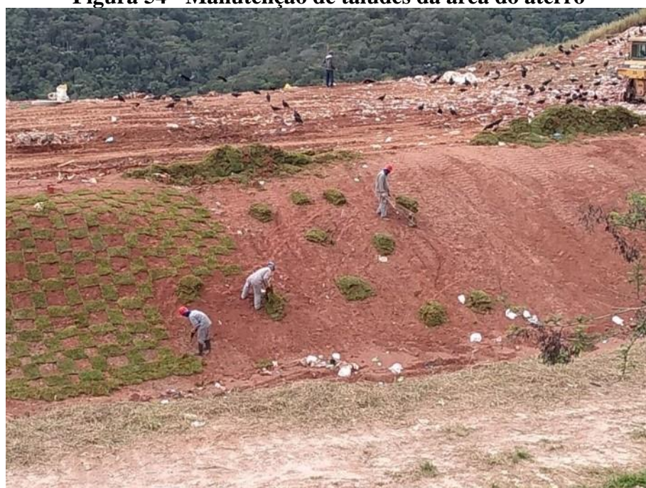
Figura 54 - Manutenção de taludes da área do aterro
