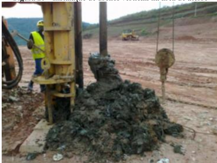
Figura 20 – Instalação de drenos verticais na área do aterro
