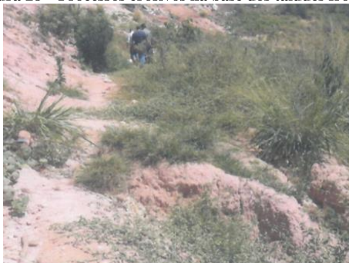
Figura 28 – Processos erosivos na base dos taludes frontais
