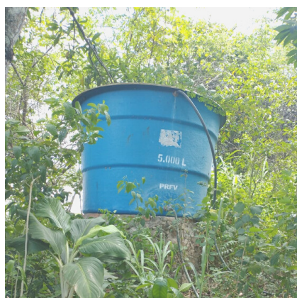
Figura 6: Caixa d'água utilizada para armazenar e elevar a pressão da água do sistema de irrigação.
