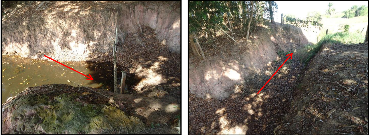
figura 5 – Vertedouro da barragem, um canal de terra aberto na ombreira esquerda.
