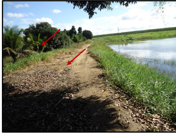
Figura 3 – Mostra o talude de montante revegetado com capim e a crista do barramento.
