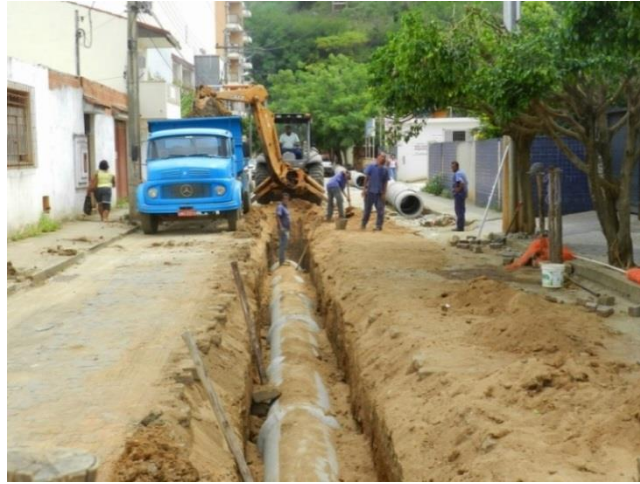
Foto 8: Tubulação de 600mm.
