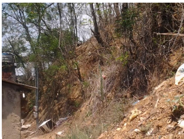
Figura 6. Corte de Talude em ângulo de 90º e construção ao lado, sem contenção
