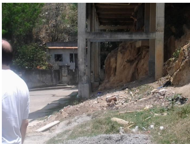
Figura 5. Bases estruturais de construções aparentes, associado à erosão do solo.
