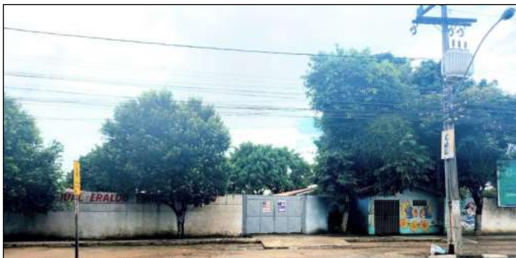
Figura 02 – Fachada do Colégio Estadual Eraldo Tinôco de Mello
