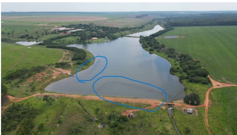
Imagem 2: Imagem realizada pelo drone, em vistoria, verificando existência de patologias no talude como erosões, e possibilidade da ocorrência de ruptura em cascada.
