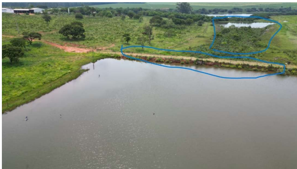
Imagem 4: Vistoria com drone possibilidade de identificar umidade na região a jusante da barragem e presença de vegetações nos taludes.
