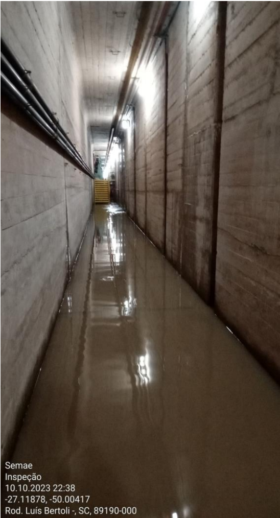
Figura 2 –Drenagem galeria deficiente – percolação concretagem alteamento x drenos fundação
