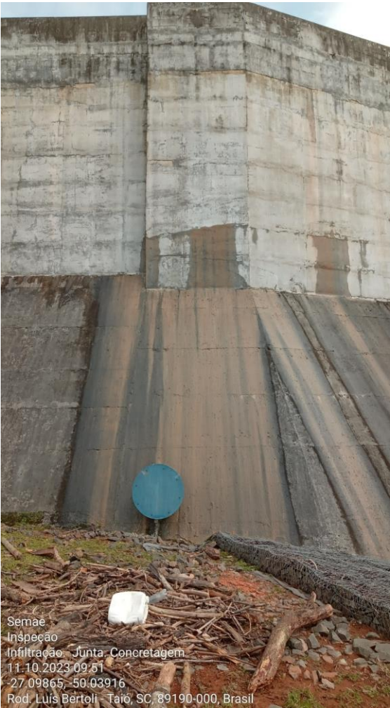
Figura 1 - Percolação no paramento de jusante.
