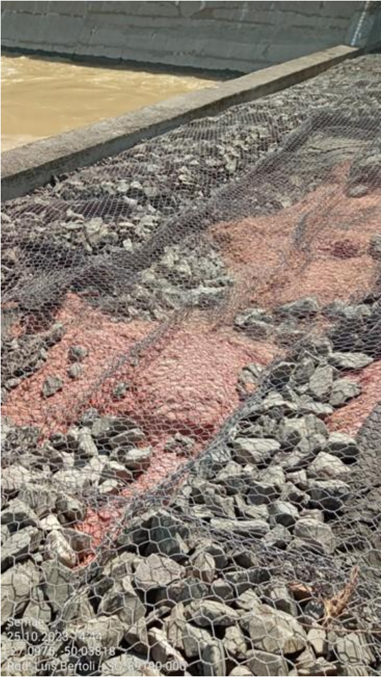
Figura 3 – Erosão e rompimento de drenagem e colchão Reno - avaliar comportamento do escoamento para maximorum.
