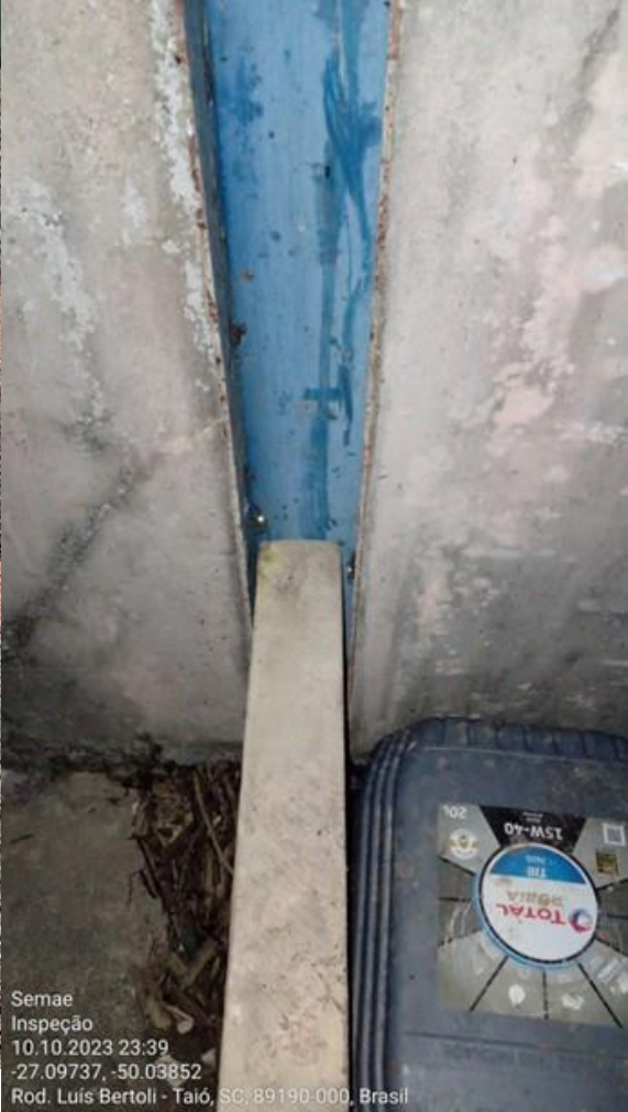
Figura 4– Ausência Proteção ao acesso as galerias ( Stop log) – risco alagamento
