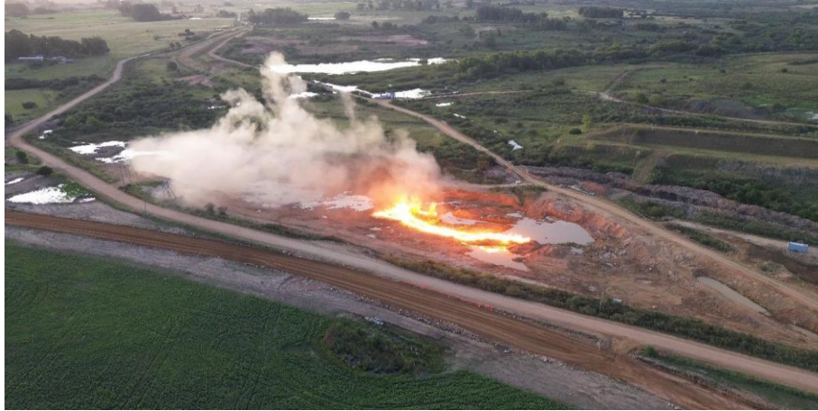
Figura 8 – Atividade de desmonte de rochas – Barragem de Arvorezinha. Fonte: Acervo próprio, 2024.
