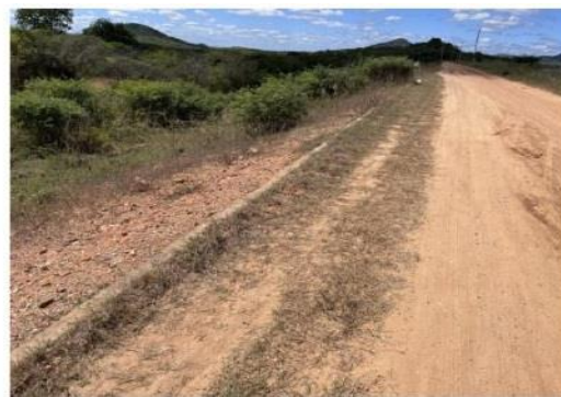
Figura 4 - sarjeta obstruída.
