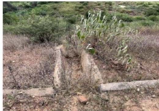
Figura 5 - canaleta quebradas/obstruídas.
