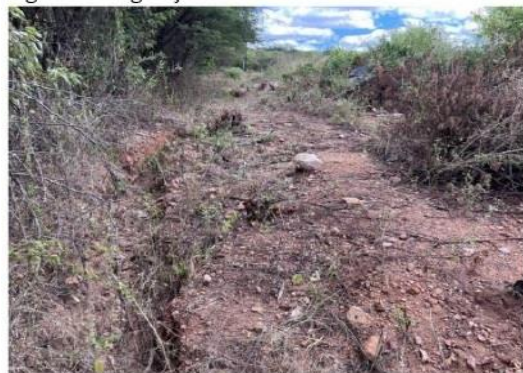
Figura 2 - erosão no encontro de ombreira
