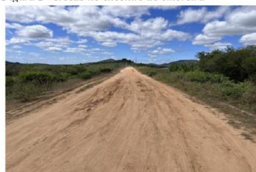
Figura 3 - falta de revestimento no coroamento.
