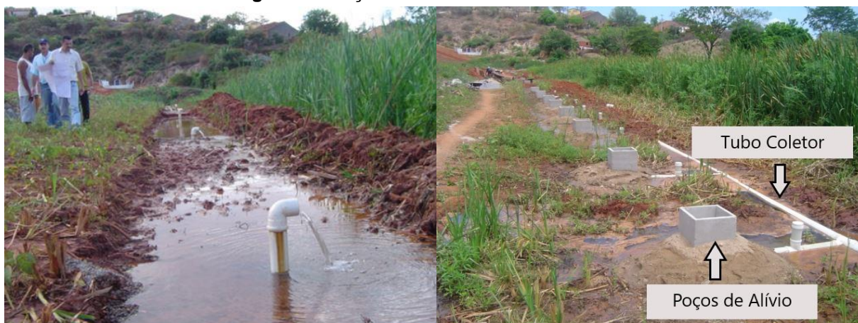
Figura 7 – Poços de alívio e sistema coletor
