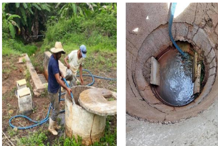
Figura 11 – Limpeza de poços de visita e tubulação da trincheira drenante
