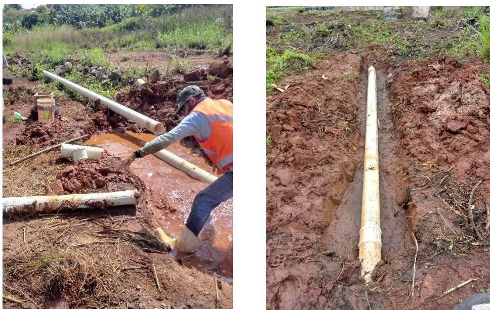
Figura 14 – Manutenção do sistema coletor secundário
