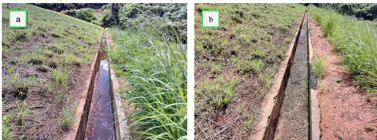
Figura 19 - Canaletas de drenagem antes (a) e após(b) a intervenção
