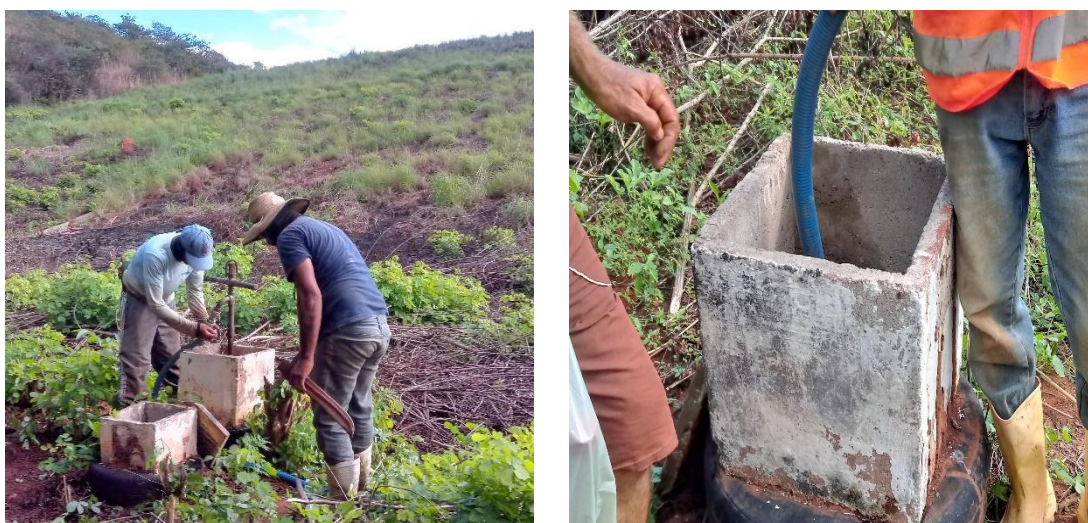
Figura 13 - Limpeza dos poços de alívio
