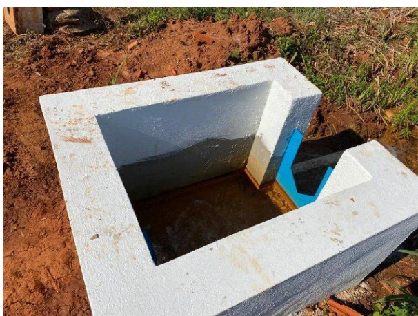
Figura 18 – Medidores de vazão região a jusante
