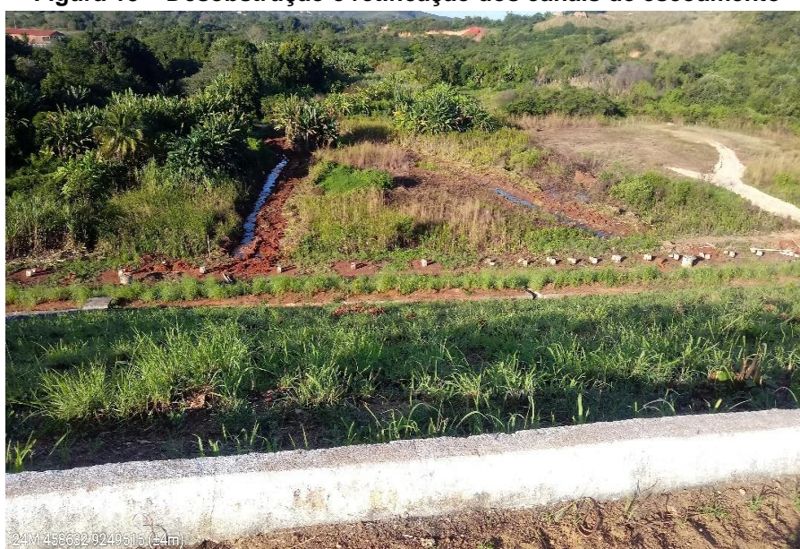
Figura 15 – Desobstrução e retificação dos canais de escoamento
