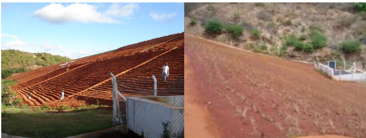
Figura 8 – Recomposição do talude de jusante e plantio vegetal
