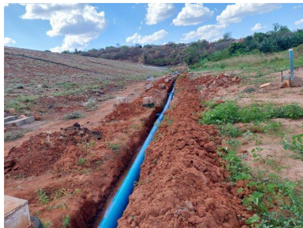
Figura 17 – Substituição dos tubos do sistema coletor
