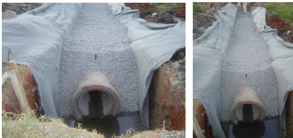
Figura 9 – Trincheira Drenante
