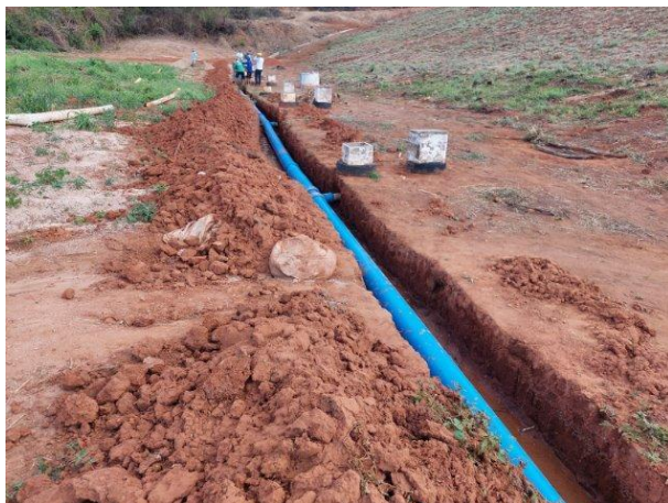
Figura 17 – Substituição dos tubos do sistema coletor
