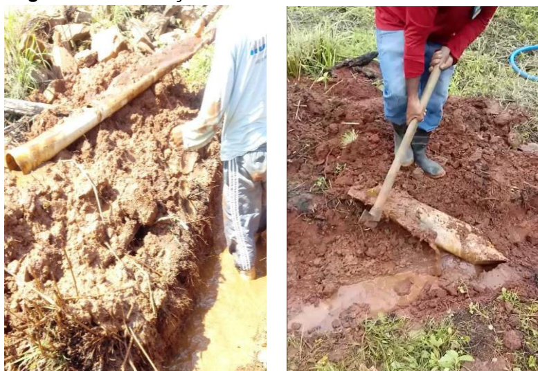
Figura 12 – Tubulação obstruída sistema coletor secundário
