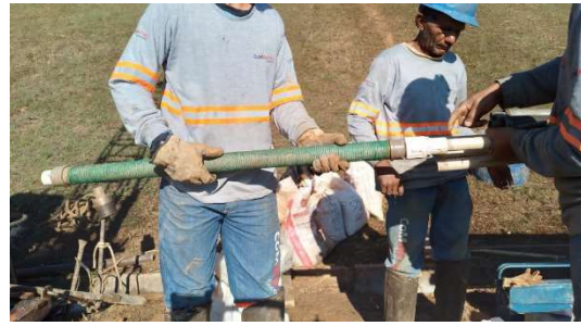
Figura 4 – Montagem do bulbo do piezômetro para inserção no furo.
