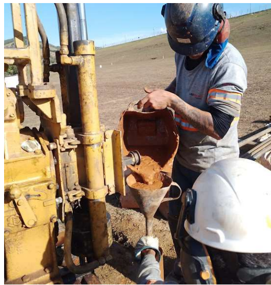
Figura 8 – Aplicação do selo de solo/cimento/bentonita.
