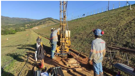
Figura 3 – Perfuração com sondagem rotativa.
