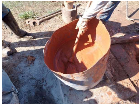
Figura 6 – Mistura da calda de solo/cimento/bentonita para confecção do selo impermeável.
