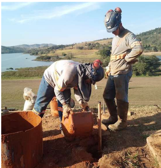
Figura 7 – Aplicação do selo de solo/cimento/bentonita.
