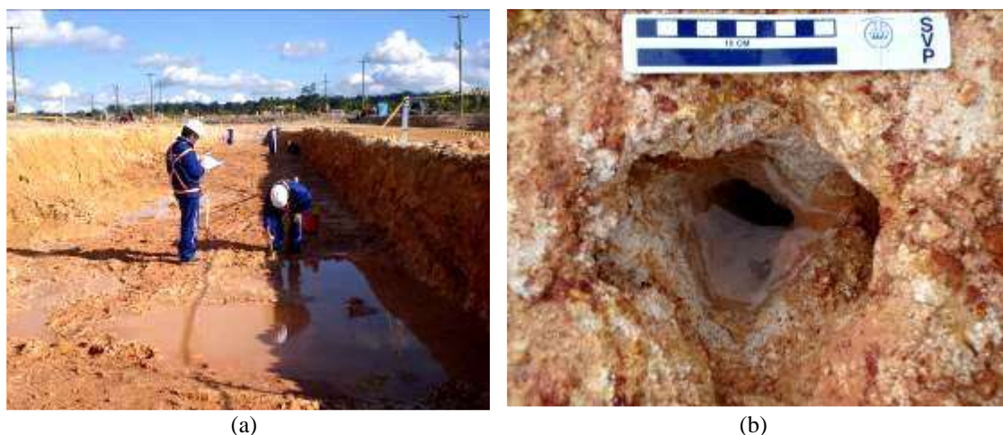
Figura 2-2 – Canalículos encontrados nas fundações de barragem em Rondônia (fotos do autor). (a) Identificação de canalículos durante o monitoramento das escavações. (b) Detalhe dos canalículos na fundação da barragem. Imagens do autor.
