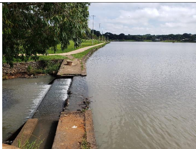
Figura 65. Vista do vertedor com sinais de desgaste concreto.
