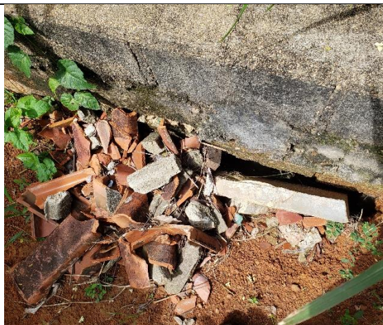
Figura 61. Vista de dano estrutura no muro do canal de restituição.
