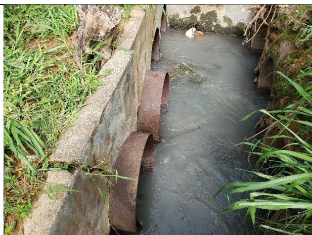
Figura 56. Vista da segunda estrutura de bueiro com dano estrutural significativo.
