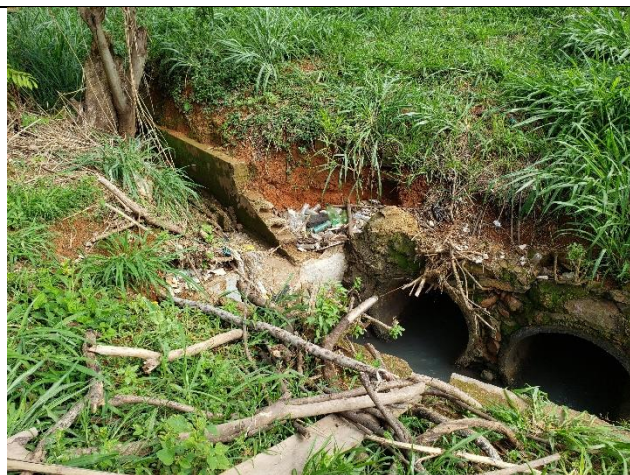
Figura 55. Vista da segunda estrutura de bueiro com bastante dano estrutura.
