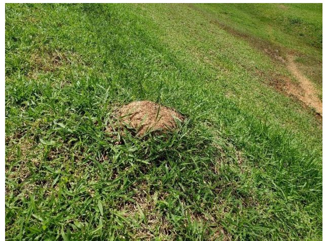
Figura 46. Vista de formigueiro no talude de jusante.
