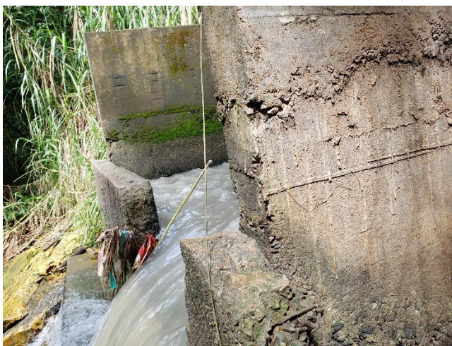
Figura 32. Presença de anomalia com dano no ressalto ao final do canal.
