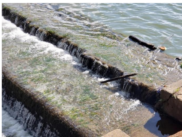
Figura 25. Vista do vertedouro em soleira livre e das anomalias identificadas.
