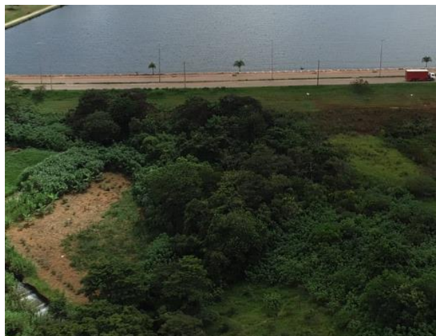
Figura 24. Presença de vegetação de grande porte no pé da barragem.
