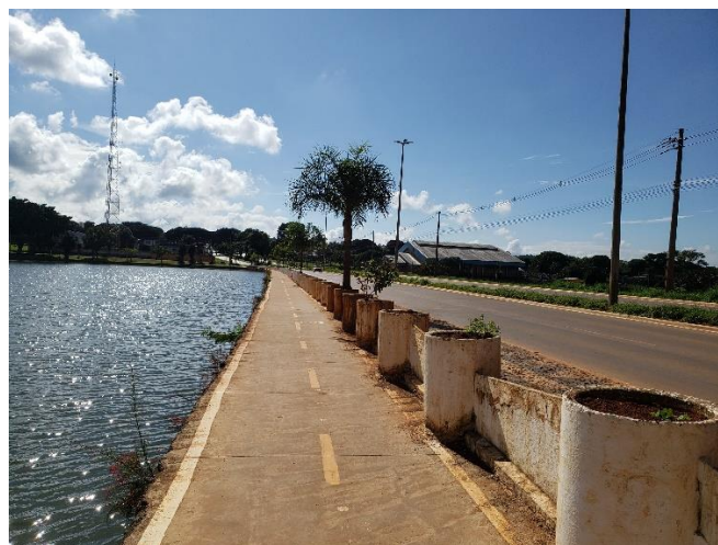
Figura 11. Crista da barragem composta por dois níveis, na primeira pista de pedestres e ciclistas e, no segundo nível, a avenida LW1.
