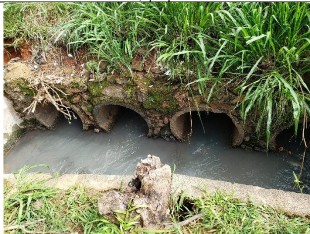
Figura 53. Vista da segunda estrutura de bueiro com bastante dano estrutural, rachadura.
