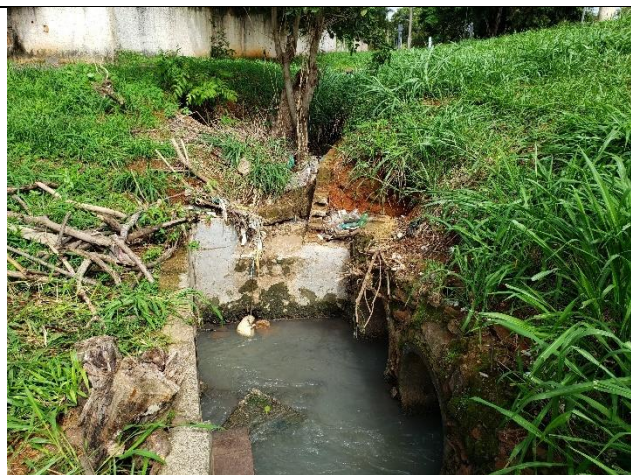
Figura 54. Pequena Bacia formada entre as duas estruturas de bueiro, sendo possível ver presença de lixo e entulho e danos estruturais.
