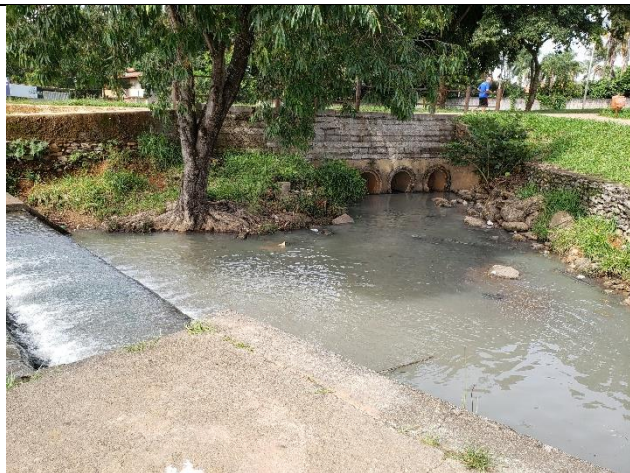
Figura 67. Vista da bacia de amortecimento após o vertedor, com vista à primeira estrutura de bueiro.
