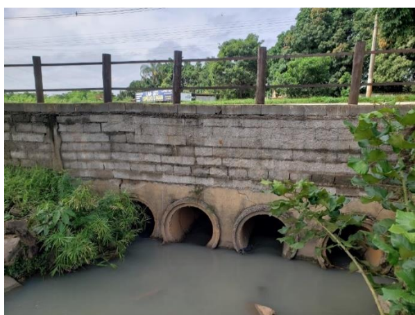
Figura 27. Vista do extravasor composto por um sistema de bueiro em manilha de concreto.
