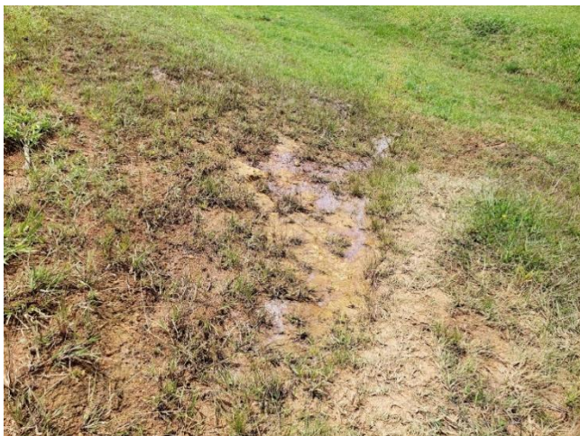
Figura 19. Surgência de água no talude de jusante.
