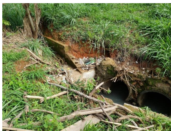
Figura 28. Mais danos na estrutura do bueiro do extravasor.
