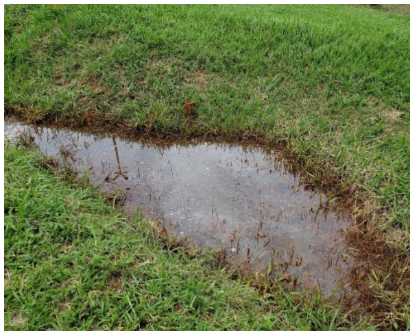
Figura 20. Água empoçada no talude de jusante.
