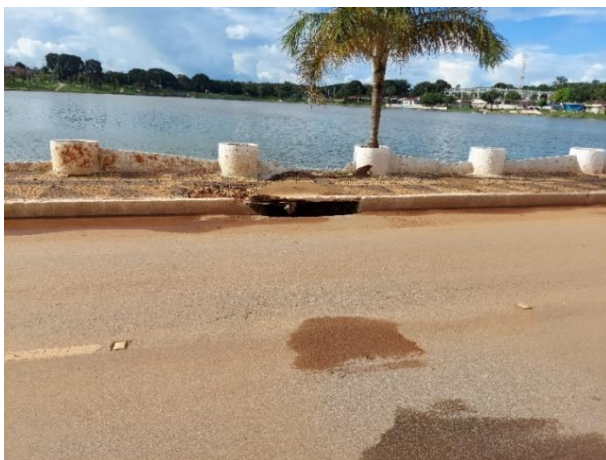
Figura 14. Presença de dano no passeio de pedestres e no meio fio da pista.
