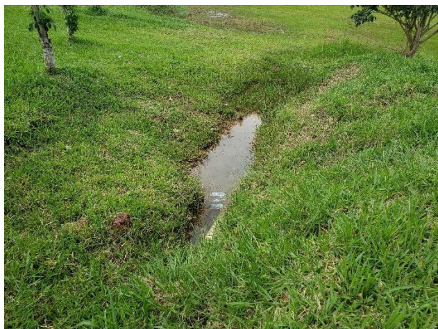
Figura 49. Vista de uma tubulação que sai do maciço da barragem com acúmulo de água.
