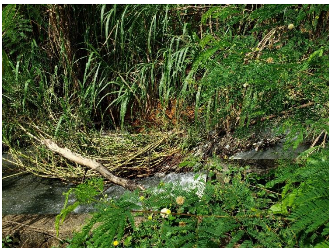
Figura 31. Presença de anomalias no canal de restituição, com bastante presença de vegetação, dano severo na parede direita do canal, todo em concreto.
