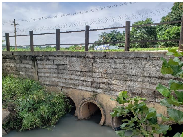
Figura 68. Vista da estrutura do bueiro com rachadura logo acima da primeira e segunda manilhas; a esquerda há um deslocamento da estrutura.
