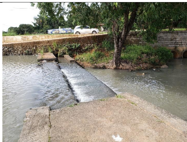
Figura 64. Vista do vertedor com sinais de desgaste concreto.
