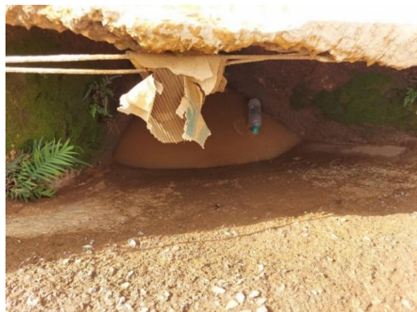
Figura 15. Presença de água empoçada na boca de lobo que compõe a drenagem da via.
