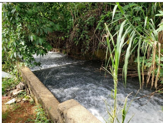
Figura 58. Canal de restituição, que funciona também como canal do lançamento de águas pluviais do reservatório.
