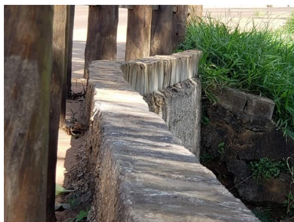
Figura 26. Presença de recalque na estrutura sobre o primeiro bueiro.
