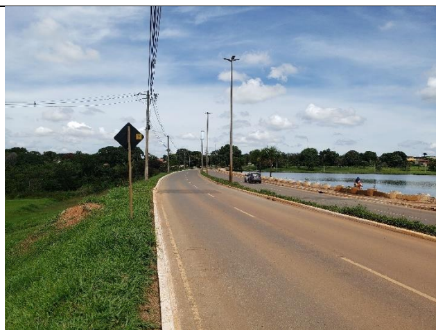
Figura 42. Vista da crista da barragem e de um ponto com formação erosiva no talude de jusante. Presença de pedestre e veículo passando sobre a crista.
