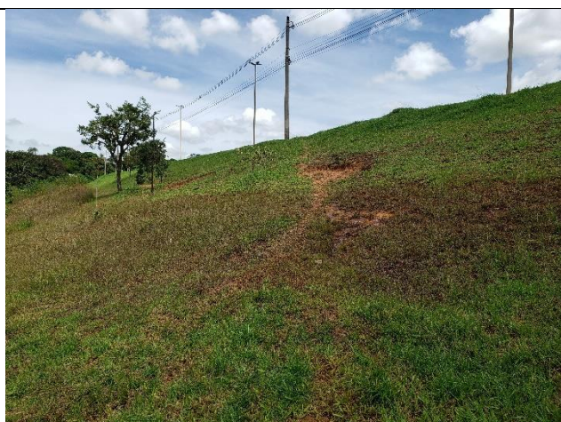
Figura 51. Vista de processo erosivo no talude de jusante com surgência de água.
