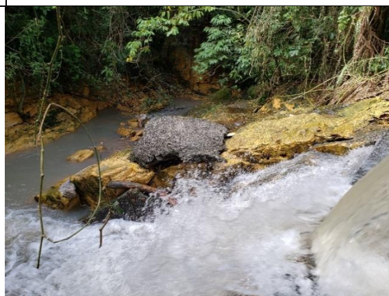
Figura 63. Presença de processo erosivo na descarga da água o corpo hídrico.
