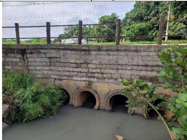
Figura 52. Vista da primeira estrutura de bueiro que conduz água da bacia de amortecimento até a segunda estrutura de bueiro.
