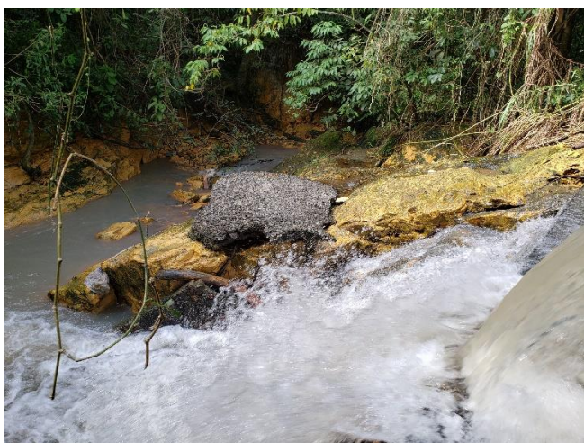
Figura 33. Presença de formação de processo erosivo logo após o canal, no retorno de água ao córrego.
