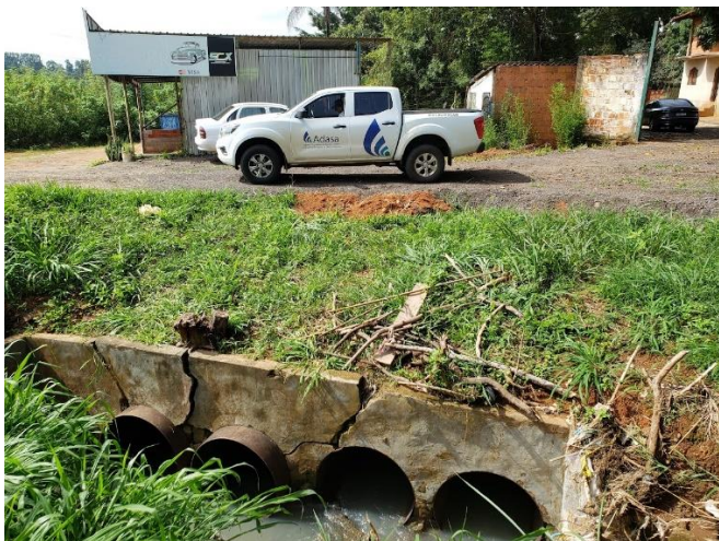
Figura 29. Segunda estrutura em bueiro que também compõe o extravasor.
