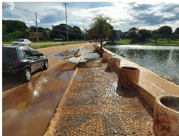
Figura 16. Presença de água empoçada na via.
