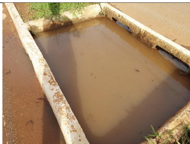
Figura 41. Vista de água acumulada na rede de drenagem da via e da crista do barramento.
