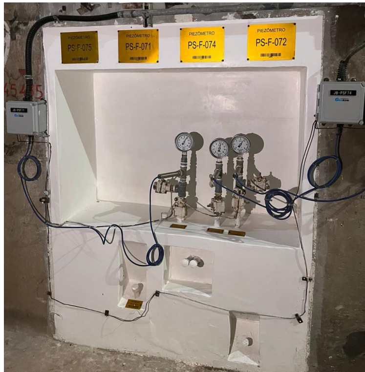
Figura 8 – Medidores de pressão dos piezômetros
