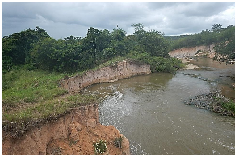
Figura 10 – Erosão em margem do canal extravasor (a) Fotografia por celular retirada em ponto de acesso à anomalia. (b) Fotografia retirada através de veículo aéreo não tripulado.
