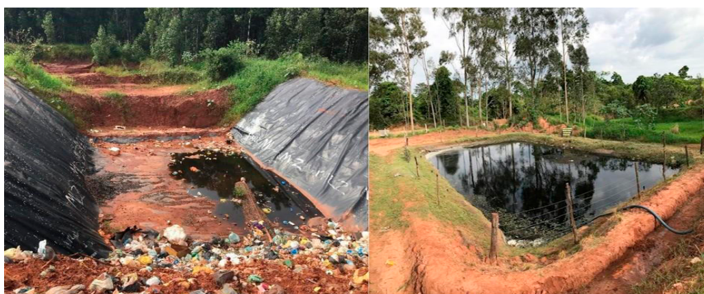
Figura 2. Sistema de drenagem de líquido percolado
