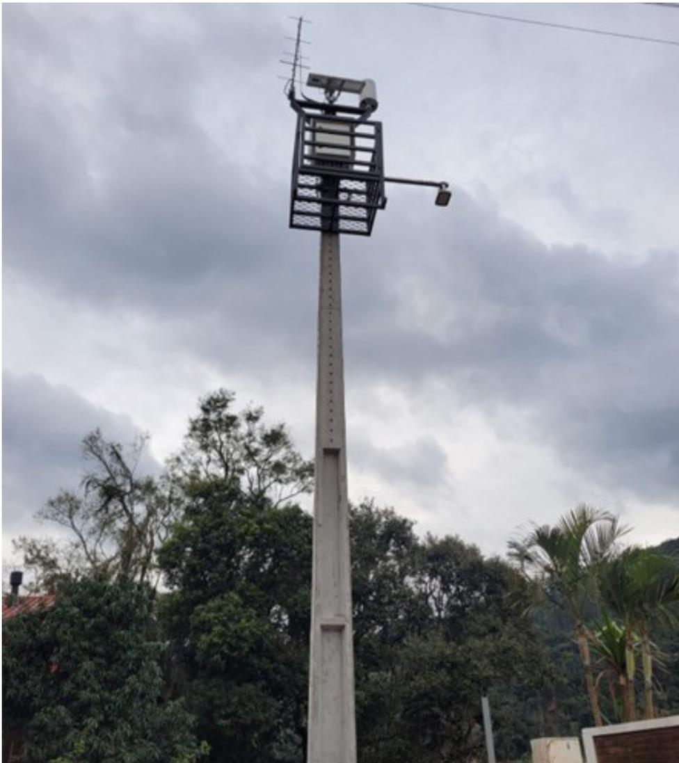
Estação fluviométrica no Rio Taquari em Muçum, reconstruída após a enchente, de forma mais segura para garantir a continuidade da operação.
