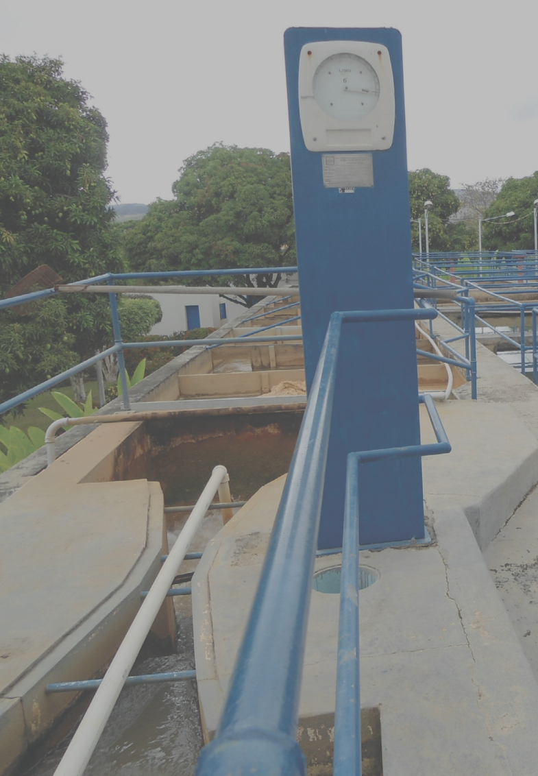
Calha Parshall instalada em sistema de tratamento de água em Baixo Guandu (MG) Banco de Imagens ANA
