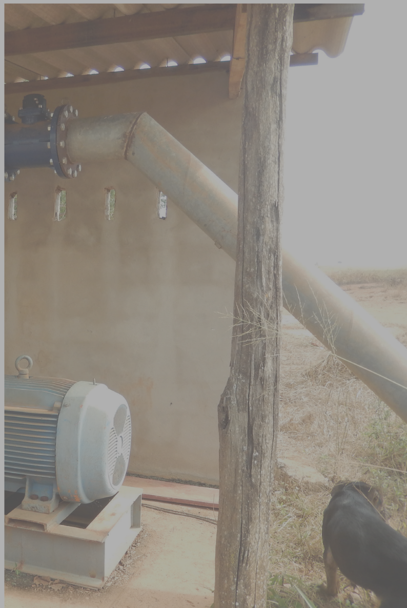
Equipamento eletromagnético de carretel instalado em tubulação de adução de água em Brasília (DF) Banco de Imagens ANA
