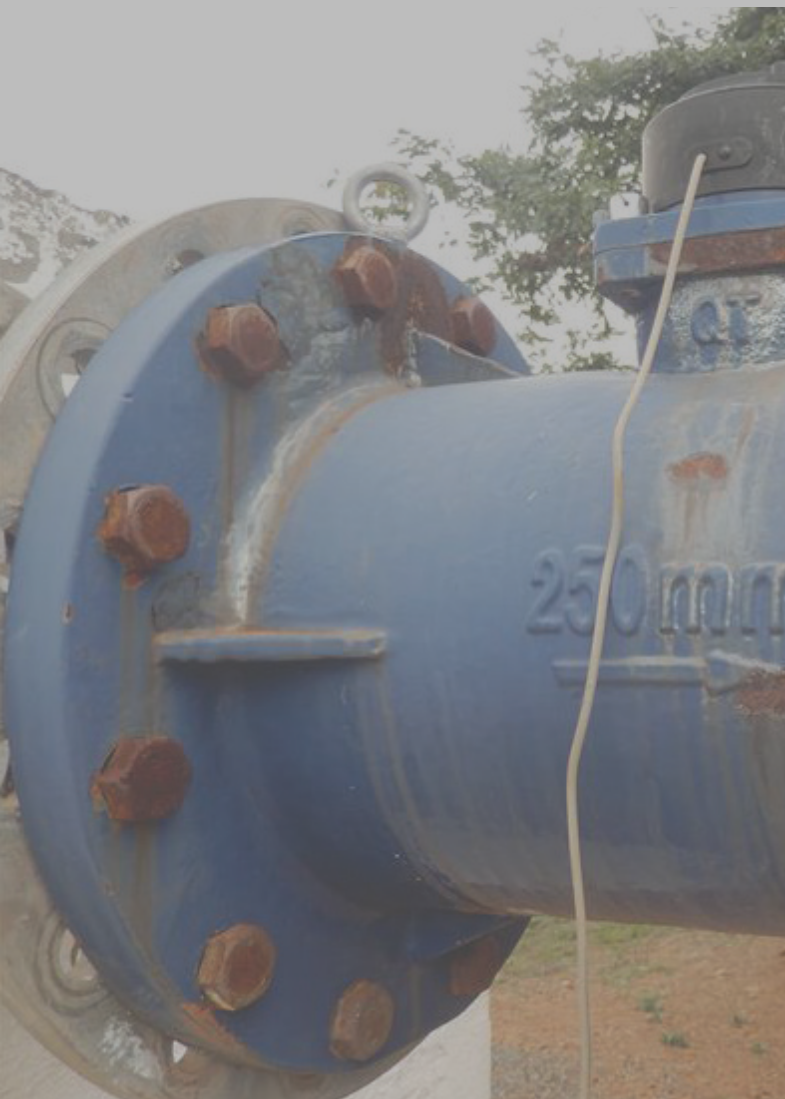
Hidrômetro instalado em empreendimento com uso de recursos hídricos em Paracatu (MG) Banco de Imagens ANA
