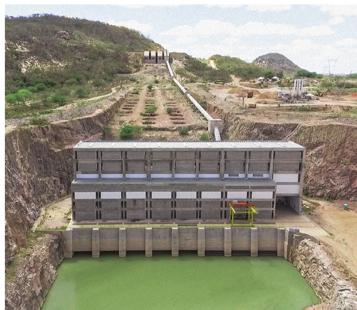
EBI-3 - Eixo Norte Execução das obras da Estação de Bombeamento EBI-3 no Eixo Norte conduzidas pelo MIDR
