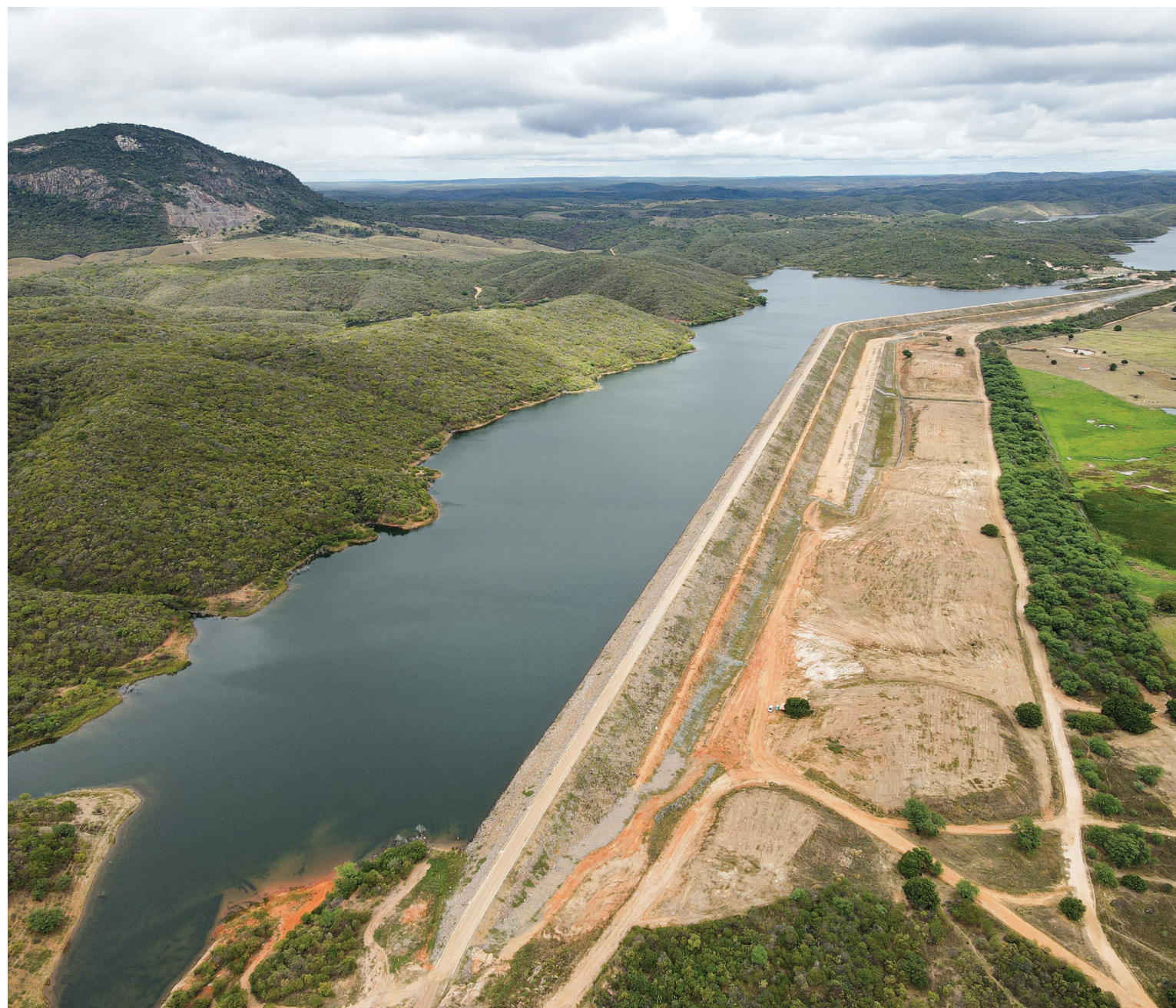
Reservatório Cana Brava - Eixo Norte Foto: cedida pelo MIDR
