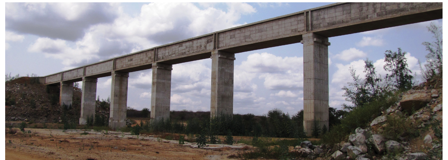
Aqueduto Barreiros - Eixo Leste Execução das obras do Aqueduto Barreiros no Eixo Leste conduzidas pelo MIDR
