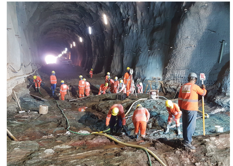
Túnel Cuncas 1 - Eixo Norte Foto: Bruno Rebouças / Banco de Imagens ANA
