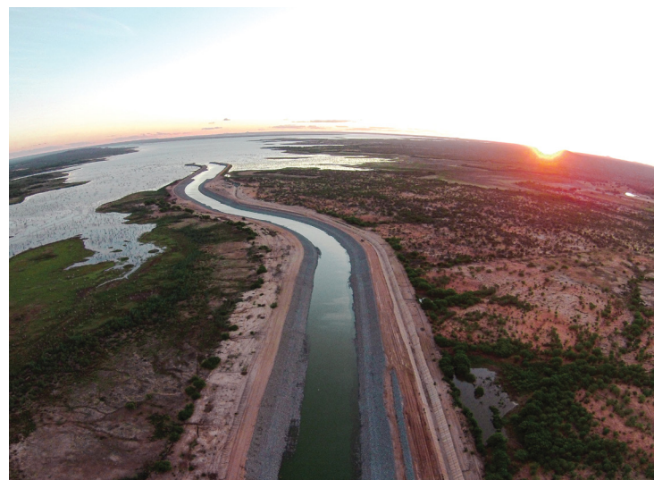
Canal de aproximação - Eixo Leste Execução das obras do canal de aproximação do Eixo Leste conduzidas pelo MIDR
