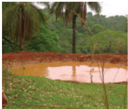
Figura 27: Bacia de infiltração de água (barraginha)
