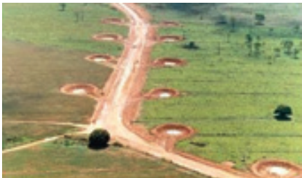
Figura 30: Estrada de terra recuperada e ladeada de barraginhas
