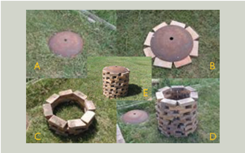
Figura 41: Sugestão para construção de depósito de lixo orgânico
