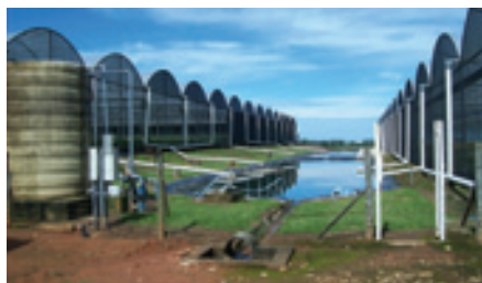
Figura 32: Captação de água de chuva em coberturas de casas de vegetação e armazenamento em reservatório superficial - Holambra-SP
